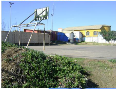
FOTOGRAFÍA DEL PREDIO
